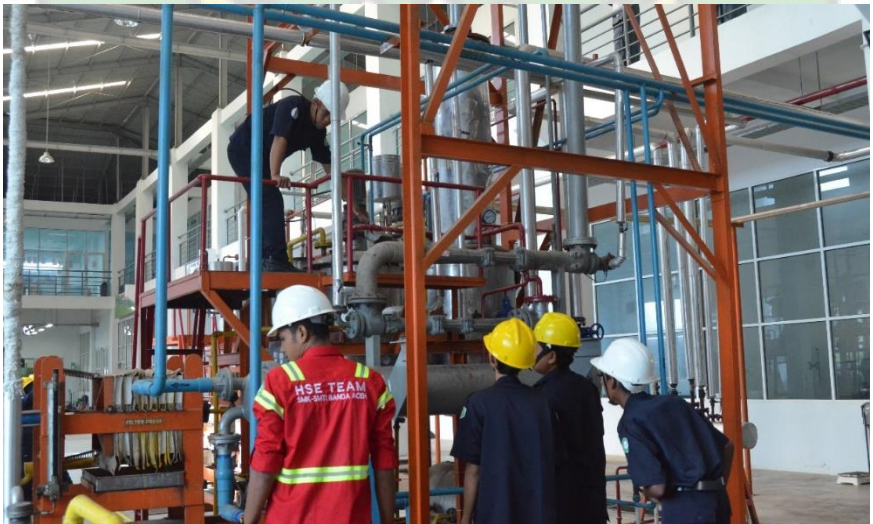
Foto 10. Praktikum Refinery Mata Pelajaran Teaching Factory di Mini Plant Gedung D (Jurusan KI)
