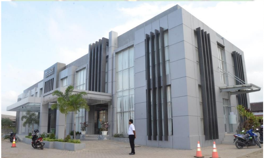
Foto 6. Gedung B, Gedung Perkantoran
