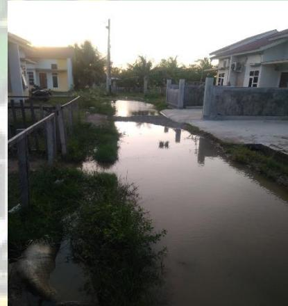
Gambar C.4 Air yang tidak dapat mengalir karena drainase yang tersumbat
