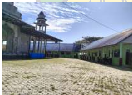
Gambar 5: Halaman dan bangunan ruang kelas MIN 7 Aceh Besar
