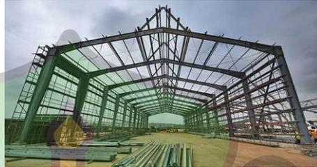
Gambar 5.35 *Portal Frame* (Rangka Portal)
