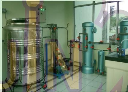
Gambar 5.52 Tangki Air, Unit *Ultrafiltrasi*, *Multimedia Filter* dan *Statik Mixer*
