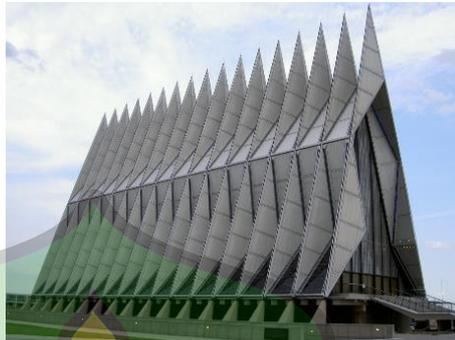
Gambar 5.37 Struktur Plat Lipat
