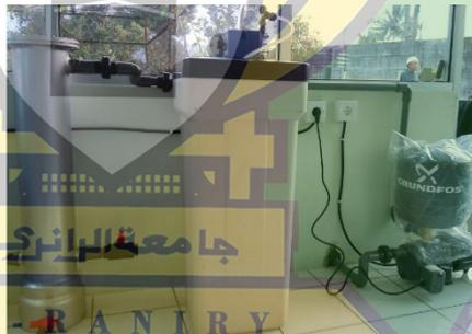
Gambar 5.53 *Statik Mixer*, Tangki Kaporit dan Pompa Umpan
