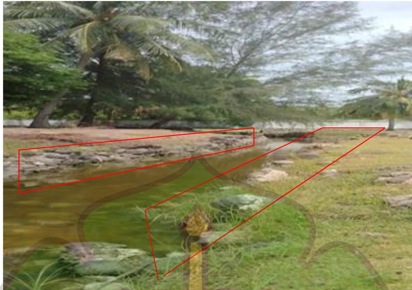
Gambar 5. 6, Dinding kanal mengalami kerusakan seperti patah, runtuh, melesak bahkan tidak nampak lagi oyif sebagai penutup dinding kanal, kanal ini berada pada sudut barat daya sampai ke arah timur. Gambar di atas diambil pada saat observasi di lapangan. (Dok. Penulis 7 Juni 2022)
