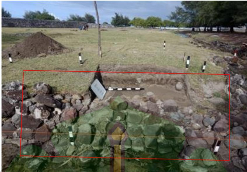
Gambar 5. 2, Kondisi struktur talud kanal arah barat daya terlihat miring, melesak, retak, runtuh dan bergeser dari tempat kedudukannya semula, bahkan juga terlihat batuan penyusun dinding talud yang terlepas dari ikatannya. Gambar talud kanal diambil pada saat ekskavasi berasama BPCB dan melibatkan mahasiswa magang dari UIN Ar-Raniry. (Dok. Penulis 21 Agustus 2021)
