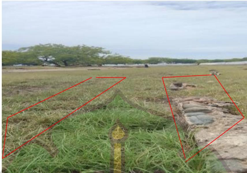
Gambar 5. 7, Kondisi dinding kanal pada bagian selatan merupakan dinding kanal yang sudah tertimbun dengan tanah pasir hanya menyisakan sebagian pondasi dengan ketinggian 10-20 cm di atas permukaan. Gambar di atas diambil pada saat observasi di lapangan. (Dok. Penulis 7 Juni 2022)
