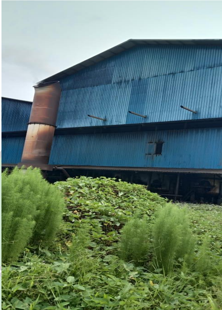
Gambar cerobong pabrik pengelolaan minyak kelapa sawit sedang tidak beroperasi
