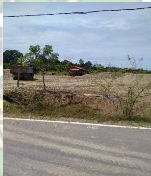
Ket: mobil angkut tanah untuk perbaikan jalan Kemukiman Buloh Seuma
