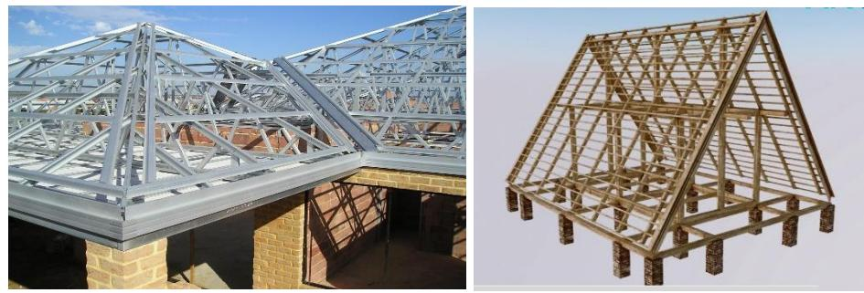
**Gambar 5. 36 Struktur atap rangka baja pada bangunan utama dan retail**
