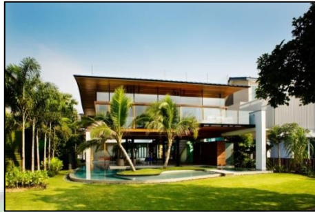
Gambar 3. 26 Fish House by Guz Architect Sumber: Archdaily.com, diakses pada 6 Juni 2021
