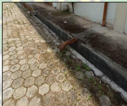
Gambar 4. 17 Drainase Pada Tapak Disekitar Bangunan
