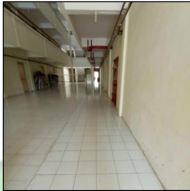
Gambar 1. 4 Interior Bangunan Eksisting Rusunawa Mahasantri
