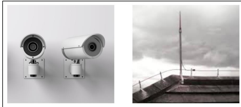
Gambar 5. 34 CCTV dan Penangkal Petir
