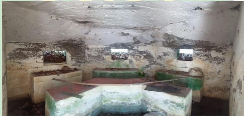
Gambar 4.3: Lubang Pengintaian/Jendela bunker dengan ukurannya; depan 60 cm, kiri 80 cm dan kanan 60 cm. (Dok. Penulis)
