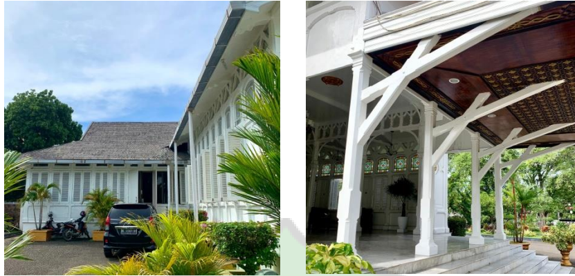
Gambar 4.15 Konstruksi atap Pendopo Sumber : Dokumen pribadi
