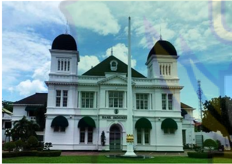
Gambar 4.3 Bank Indonesia Sumber : Dokumen pribadi
