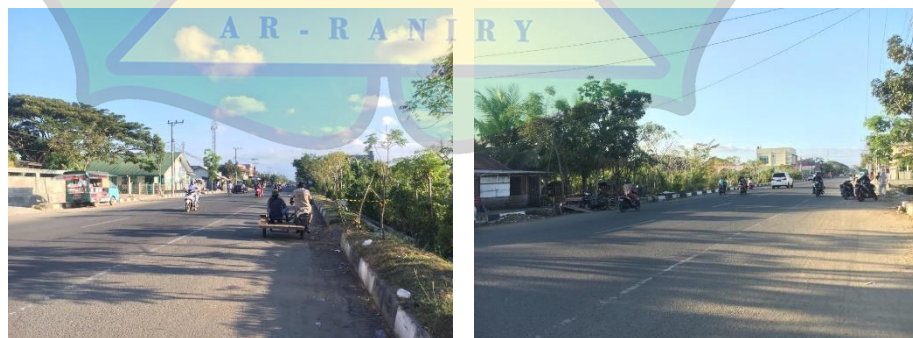
Gambar 4 .2 Jalan Arteri Sekunder di Lokasi (Sumber: Dokumentasi Pribadi,2020)
