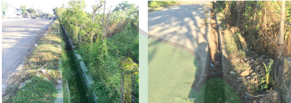
Gambar 4 .3 Saluran Drainase di Lokasi (Sumber: Dokumentasi Pribadi,2020)
