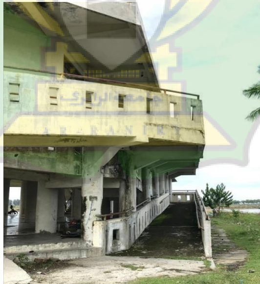
Gambar 4.5 Gedung Evakuasi (Sumber: Dokumen Pribadi)
