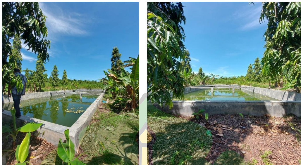
Gambar 4.3 Kondisi Eksisting Unit Kolam Fakultatif
