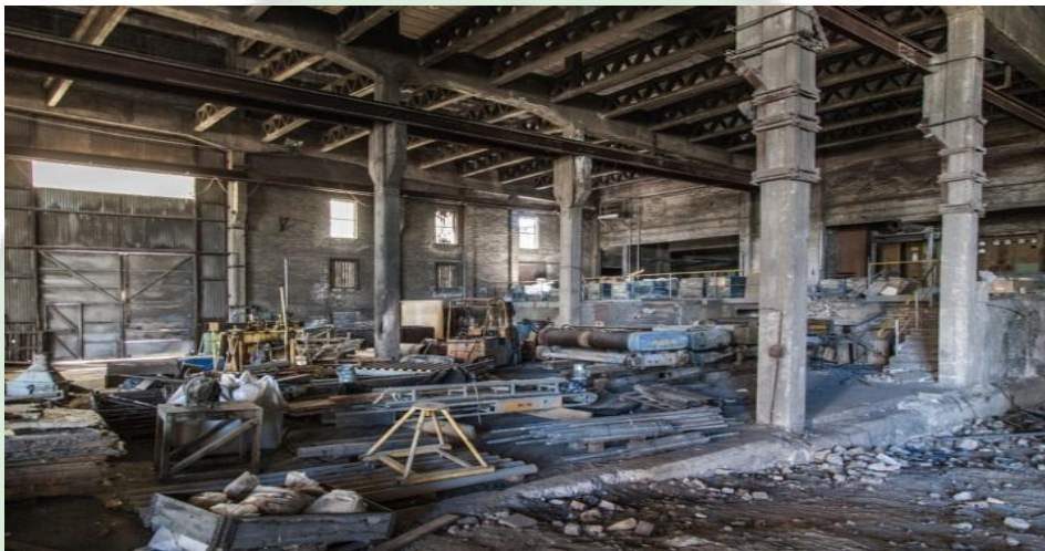
Gambar 2. 10 Pabrik kotor yang dapat menyebabkan kemacetan pekerjaan
