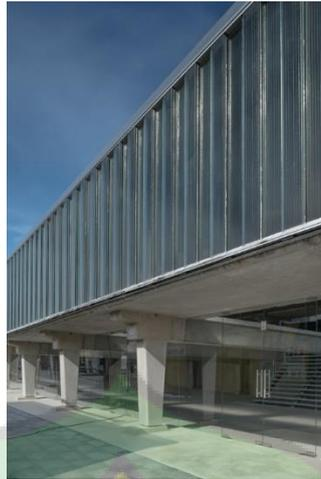
Gambar 3. 26 Material Semen Unfinishing Dan Fasad Sebagai Ventilasi
