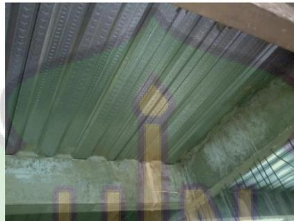
Gambar 3. 3 Bagian Bawah Struktur Lantai Plat Beton bertulang Dengan Cetakan Metal Deck
