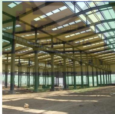
Gambar 3. 5 Penerapan Penutup Atap Metal Roof Di Sertai Struktur
