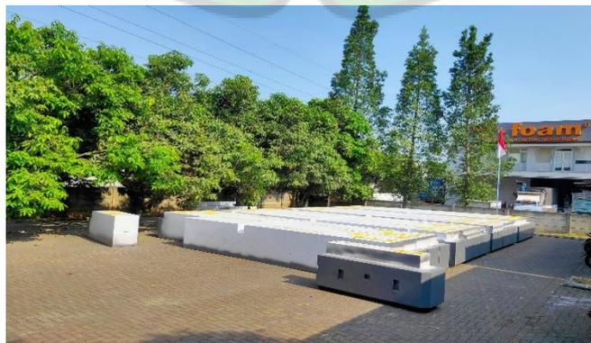
Gambar 2.9 Pondasi Styrofoam
