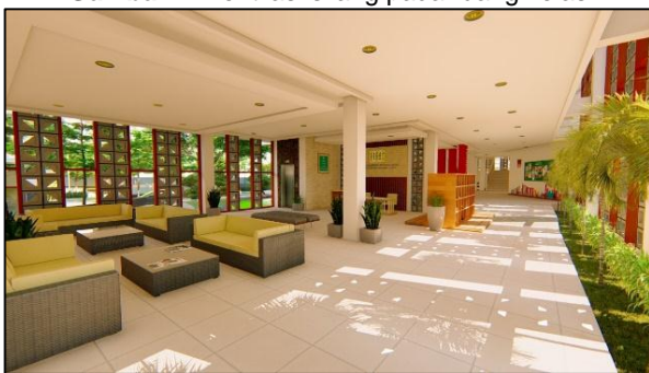
Gambar 5. Penggunaan dinding roster pada lobby bangunan mengalirkan udara ke bangunan
