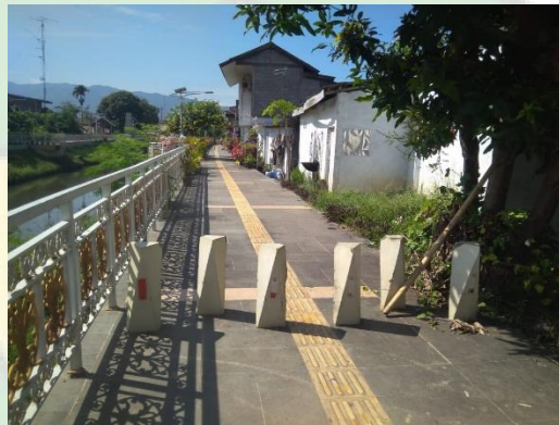
Gambar 4. 4 Penghalang kendaraan masuk Sumber: Dokumentasi pribadi
