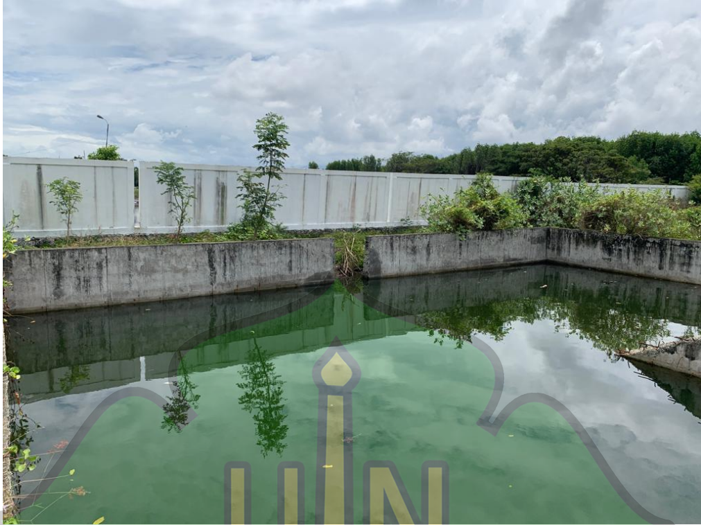
Kolam IPAL dalam Komplek Proyek Pembangunan IPAL di Gampong Pande
