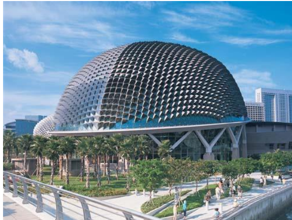
Gambar 3.14 Tampak bangunan dari luar
