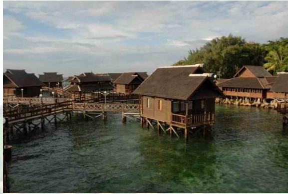
Gambar 5.14 Pondasi tiang kayu Sumber: Travelingyuk.com, diakses 27/11/2021
