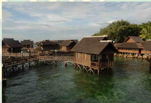
Gambar 2.25 Pondasi tiang kayu Sumber: Travelingyuk.com, diakses 27/11/2021
