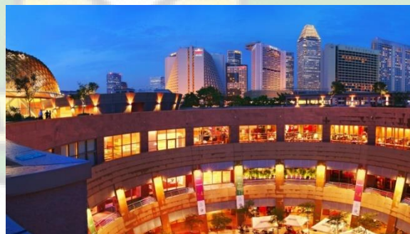
Gambar 3.11 Bukaan pada Esplanade-Theatres on the Bay Sumber: visitsingapore.com , diakses 05/12/2021
