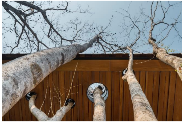
Gambar 3.6 Struktur kayu tanpa merusak pepohonan Sumber: archdaily.com, diakses 03/12/2021
