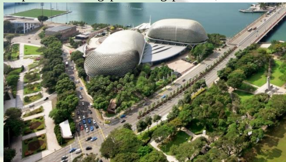
Gambar 3.15 View bangunan dari atas
