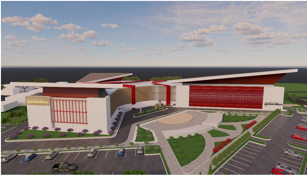
Gambar 6.53 Eksterior Bangunan (Sumber : Dokumentasi Pribadi)
