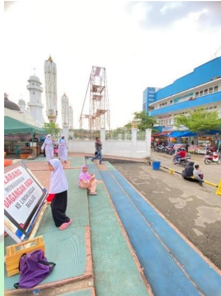
Gambar 2. 14 Ramp Gerbang Utara
