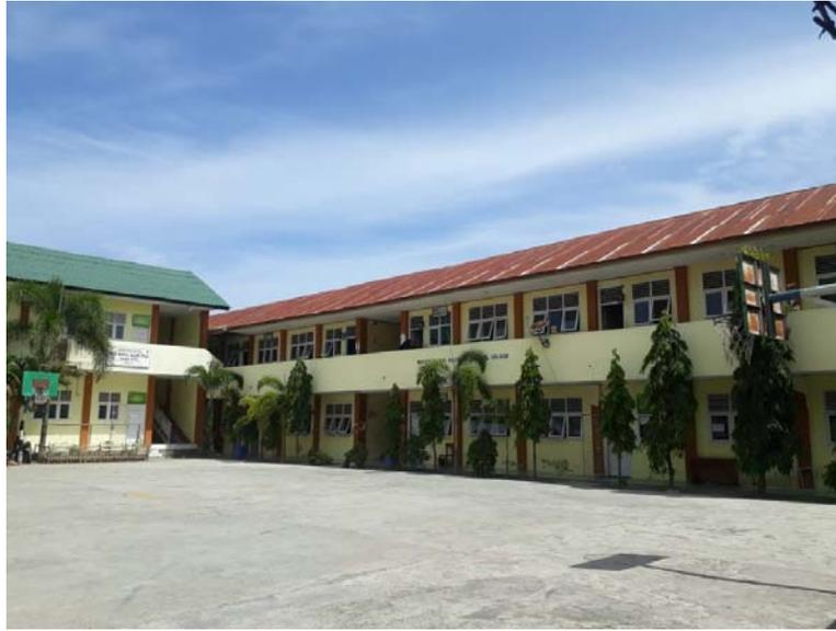
Gambar 4.2 Penggunaan beton pada struktur badan dan seng sebagai penutup atap
