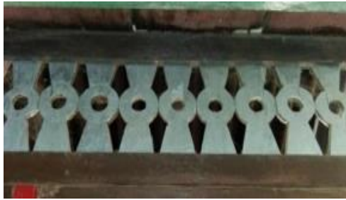
Gambar 4.66 Ventilasi Rumoh Rungko
