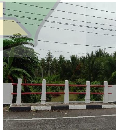
Gambar 4.11 Pembuangan Drainase Sumber: Dokumen Pribadi, 2022
