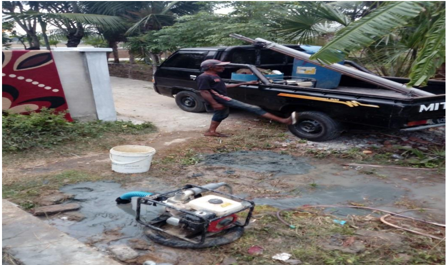
Gambar 4.17. Penggalian sumur bor di tempat pembuatan greenhouse.
