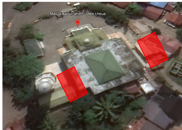
Gambar 4. 4 Tampak Atas Masjid Jami' Baiturrahim Sumber: Google Earth, 2023
