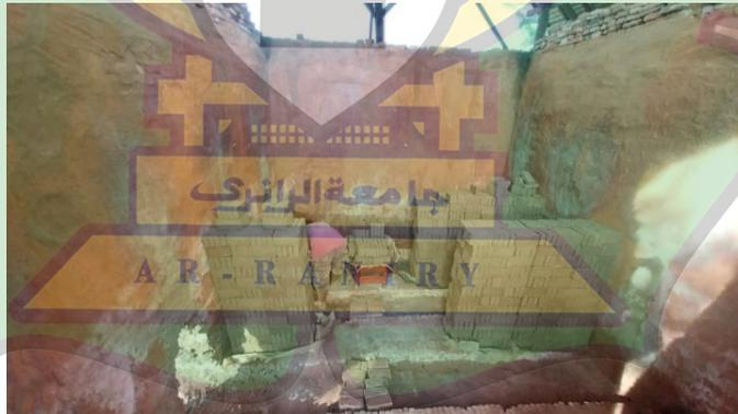
**Gambar 4.2 susunan batu bata ke dapur pembakaran**
