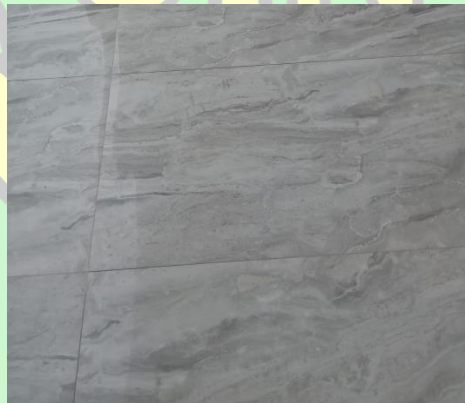
Gambar 4.9 Lantai granit pada masjid
