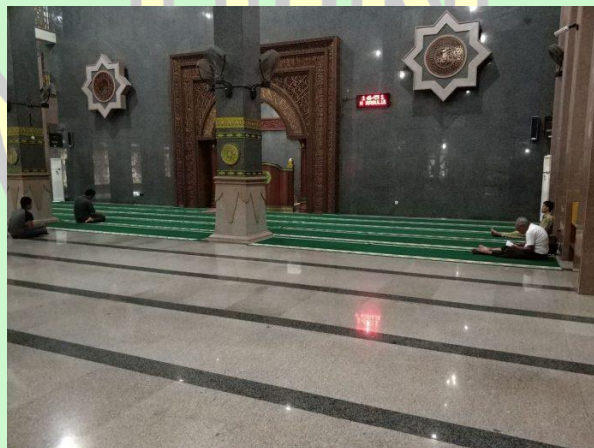
Gambar 2.6 Lantai Granit Pada Masjid
