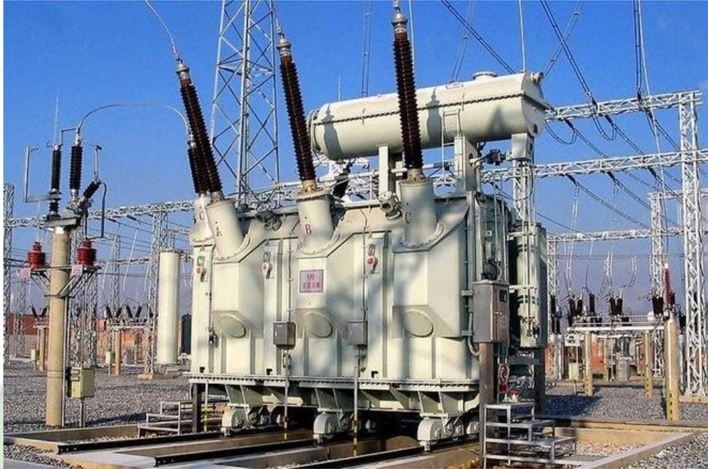
Gambar 2. 2 Gambar trafomator tenaga listrik
