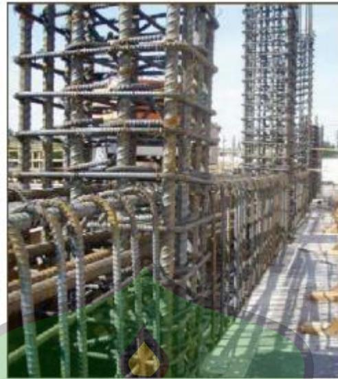
Gambar 5. 21 Contoh detailing pada hubungan balok dan kolom
