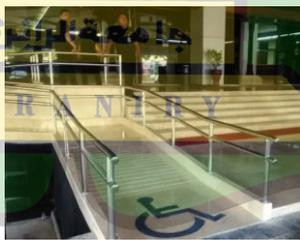
**Gambar 4.31** Ramp Akses Bangunan untuk Pengguna Kursi Roda
