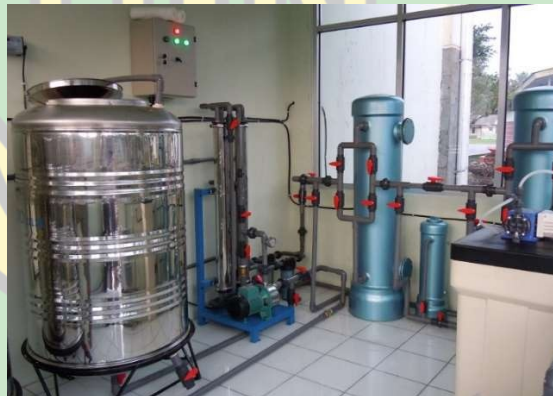
Gambar 5.36 Tangki Air Produk, Unit Ultrafiltrasi, Multi Media Filter dan Statik Mixer
