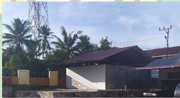
Gambar 4.10 Bak penampungan air
