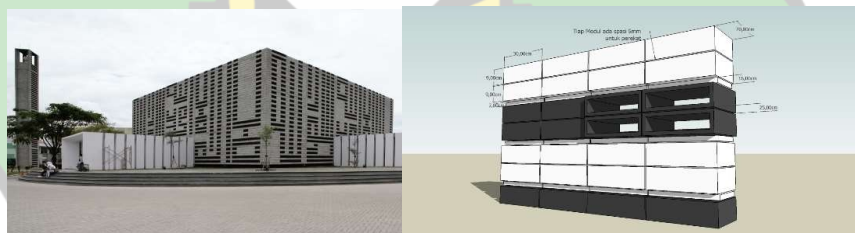
Gambar 3.22 Penyusunan Batu Masjid Al Irsyad
