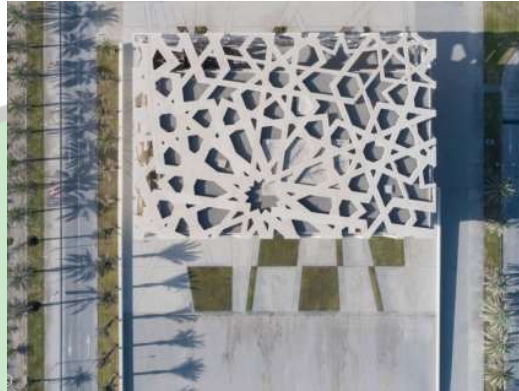
Gambar 3.15 Fasad Atap Bangunan
