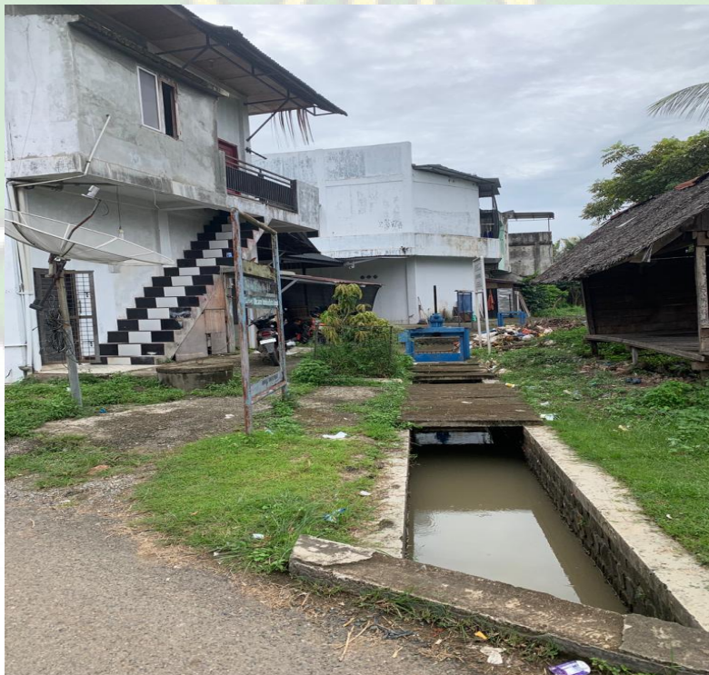
Kondisi Tanah Saluran Irigasi di Kemukiman Tungkop
