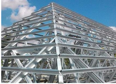
Gambar 5.25 Struktur atap baja ringan
