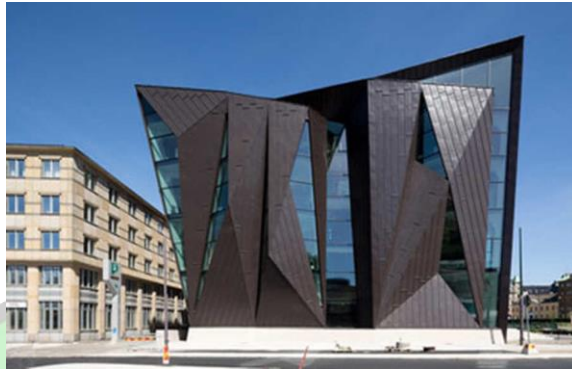
Gambar 5.83 Fasad Bangunan Bagian Depan
