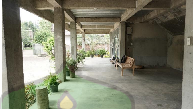
Gambar 2. 68 struktur beton pada bangunan AINS Sumber : Dokumentasi pribadi
