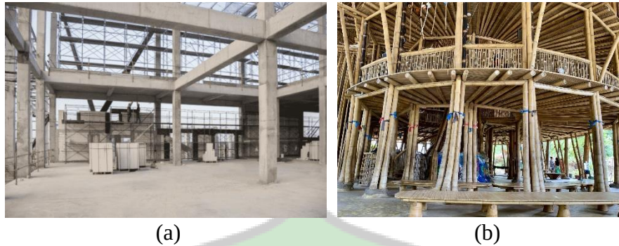
Gambar 5. 22 (a) Struktur kolom dan balok beton, (b) Struktur kolom bambu Sumber : (ruang-sipil.com, 2022)
