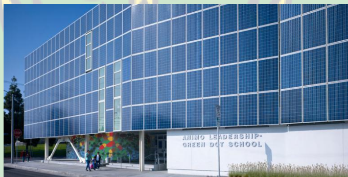
Gambar 3. 9 Panel surya pada fasad bangunan Sumber : (asset.kompas.com, 2022)
