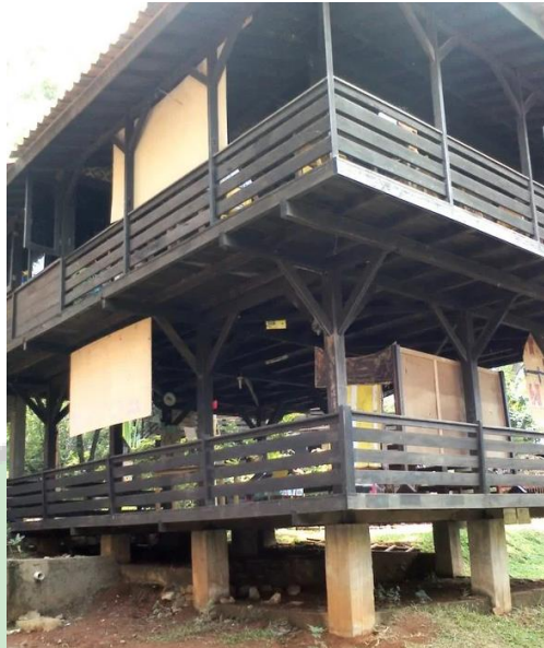
Gambar 2. 102 Struktur kayu pada gedung kelas Sumber : (Sacikeas.com, 2022)
