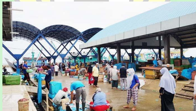
Gambar 5 bangunan pasar ikan Lampulo
