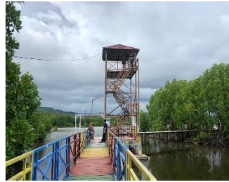
Gambar 2.35 Jembatan 2 Sumber: Dokumentasi Pribadi
