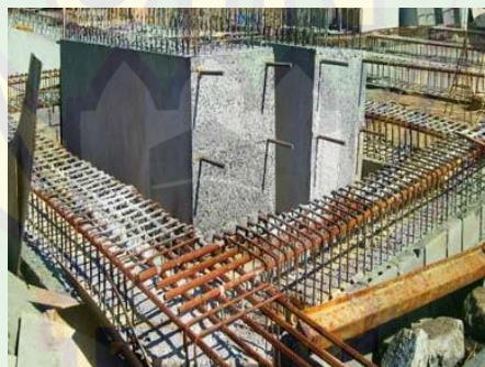
Gambar 5. 16 Konstruksi baja dan beton bertulang
