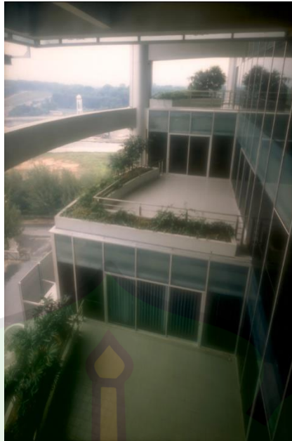
Gambar 3. 25 Ruang transisi pada Menara Mesiniaga
