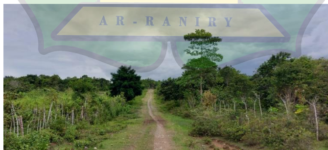
Gambar 4.29 Kondisi Jalan Menuju Site (Sumber: Analisa Pribadi 2022)
