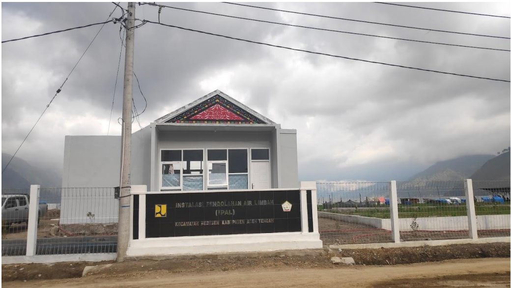
Gambar 2. Fasilitas Instalasi Pengolahan Air Limbah (IPAL) Sara Rasa di Kecamatan Bebesen Kabupaten Aceh Tengah
