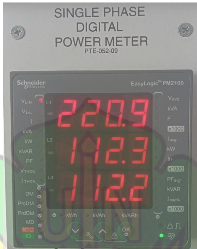
Gambar 4. 5 Tampilan Pengukuran Menggunakan *Power Meter*
