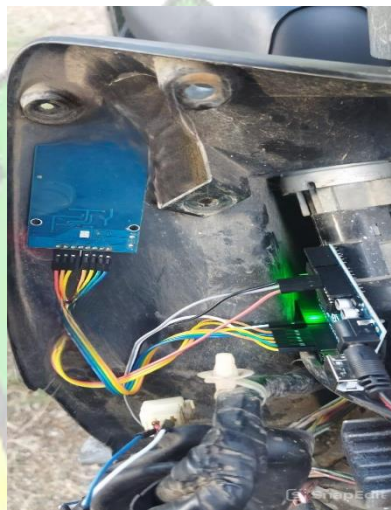
Gambar 4.2 Proses Pemasangan Modul RFID
