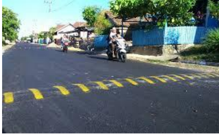
Gambar 3.13. Rubber Speed Bump yang Sesuai Standar
