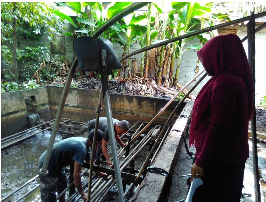
Foto 4: Wawancara dengan Bapak Rusdi sedang memperbaiki pipa pendingin minyak pala
