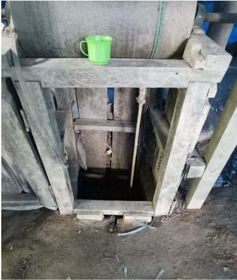
Sumber: Erni Yusfa Gambar.2 Lubang galian tampak atas
