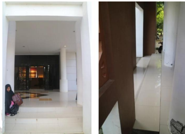
Gambar 4.6 Tangga pada pintu masuk lobby
