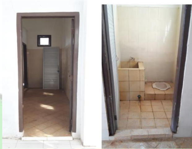
Gambar 4.23 Toilet gedung C
