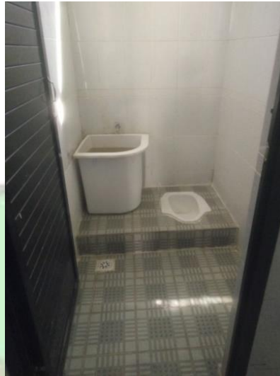
Gambar 4.17 Toilet pada gedung B
