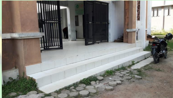
Gambar 4.22 Tangga pada pintu masuk
