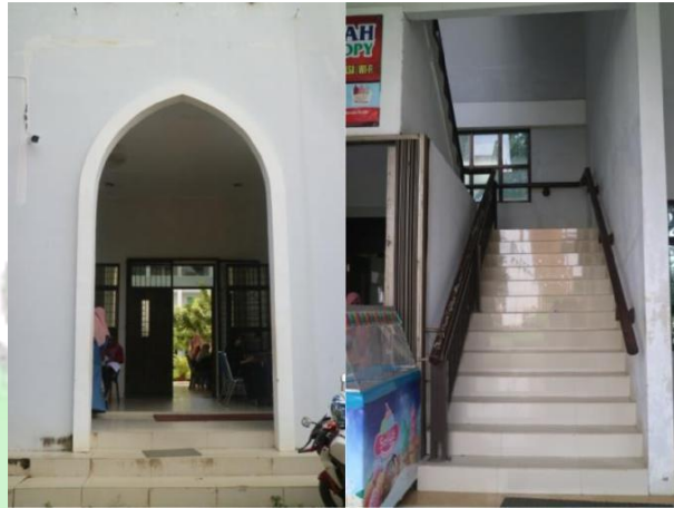
Gambar 4.16 Tangga pintu masuk sebelah kanan gedung B (kiri), tangga dalam gedung B (kanan)
