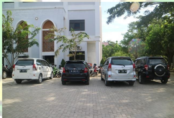
Gambar 4.12 parkir mobil gedung B
