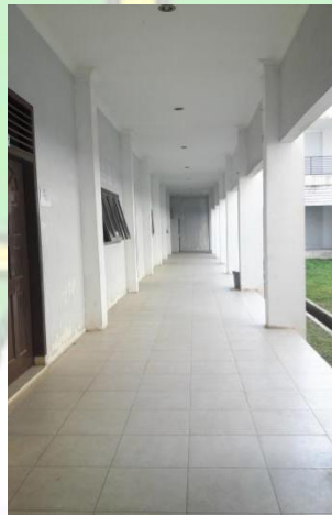
Gambar 4.20 koridor gedung C
