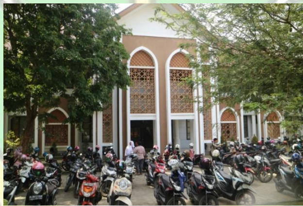
Gambar 4.2 Parkiran gedung A yang menghalangi pintu masuk
