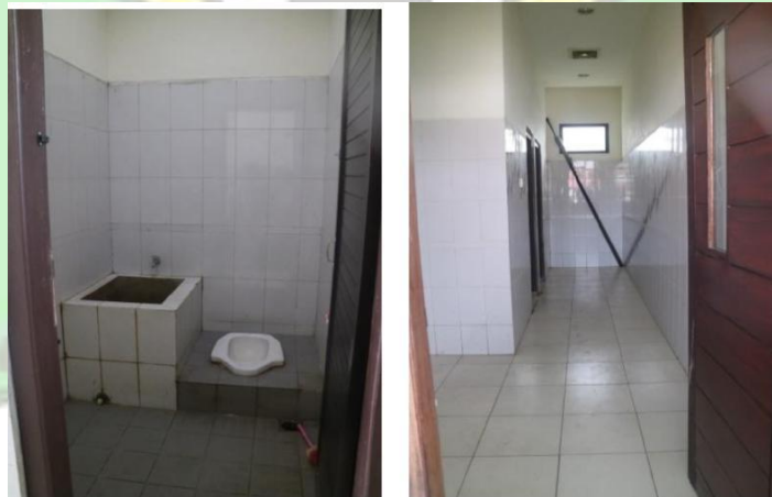
Gambar 4.9 Toilet pada gedung A
