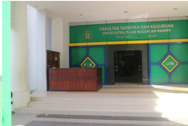
Gambar 4.13 Pintuk masuk utama gedung A
